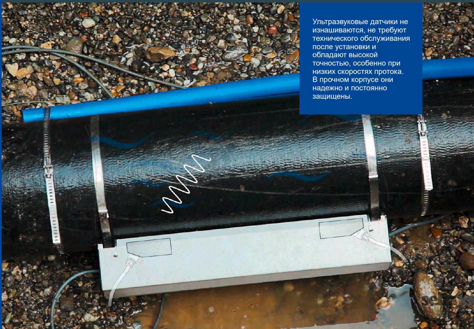
Ультразвуковые датчики не изнашиваются, не требуют технического обслуживания после установки и обладают высокой точностью, особенно при низких скоростях протока. В прочном корпусе они надежно и постоянно защищены.
